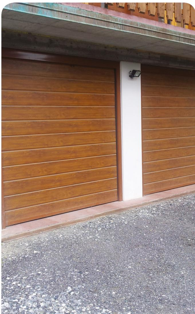
Pannelli a doghe orizzontali (passo 250 mm) costituiti da telaio in acciaio con isolamento poliuretano di spessore 40 mm, alti 500 mm.
